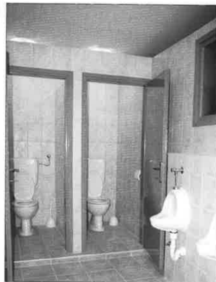
Završena obnova sanitarnog čvora u zgradi Zalan
